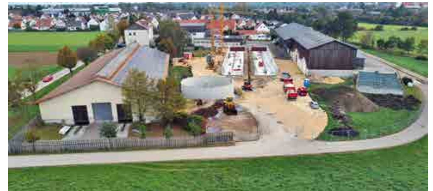
Unten: Der neue Stall und das Güllelager nehmen Form an
