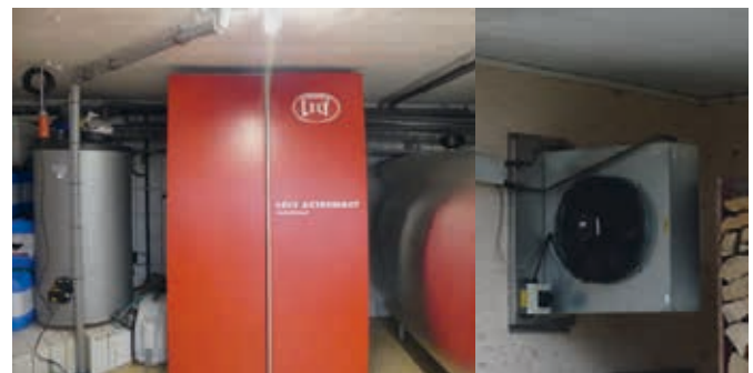
Wärmerückgewinnung in und Kühlaggregat außerhalb der Milchammer auf dem Betrieb Thomas Sirch
