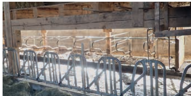
Liegeboxenstall für Mutterkühe mit Platz für die Kälber im breiten Kopfkastbereich der Kühe. Es ist eine Baulösung, die oft und erfolgreich in stroharmen Gebieten verwirklicht wird. Der Betrieb Haggenmüller (Bezachmühle) hat sich vor einigen Jahren für diese Stallvariante entschieden. Bilder: Habel
