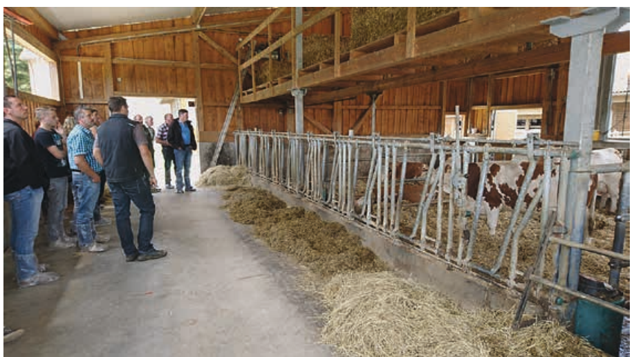
Einseitig befahrbarer Futtertisch mit Sicherheitsfressgittern
