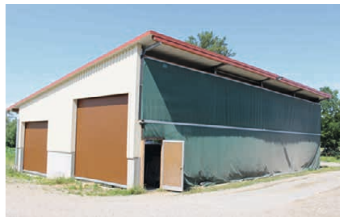
Der freistehende nach Süden ausgerichtete Kälberstall im Betrieb Ruisinger. Das Windschutznetz wird in Zukunft gegen einen curtain ersetzt.
