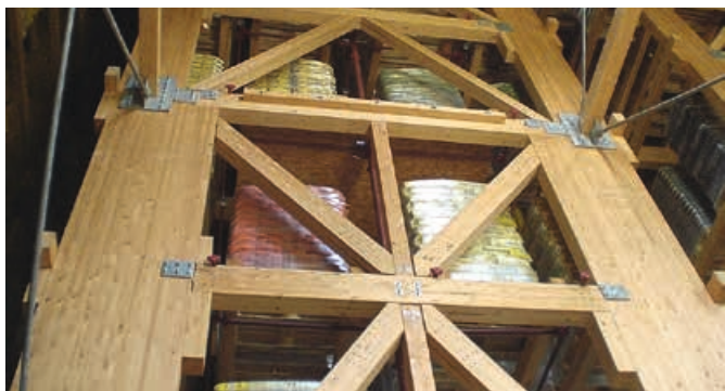
Beeindruckend und nachhaltig: Das Hochregallager wurde mit Holz aus der Region erbaut.
